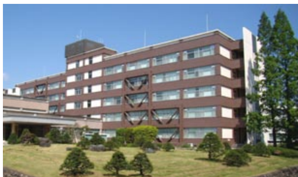
耐震補強改修工事を行った、現在のA・B棟
