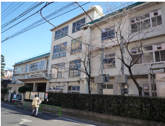
旧小学校をそのまま使っているところが素敵でした。温度や湿度対策が大変だと感じましたが、工夫が分かりました
